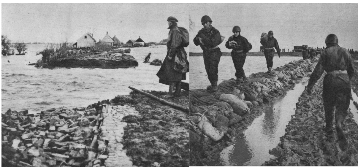
Waar men niet direct de strijd met het water kon aanbinden, schuurden de getijstroom de gaten in de dijken dikwijls tot grote diepte uit. Een van de in West-Brabant geteisterde plaatsen is Lepelstraat, waar van het land weinig meer te bekenen is.
